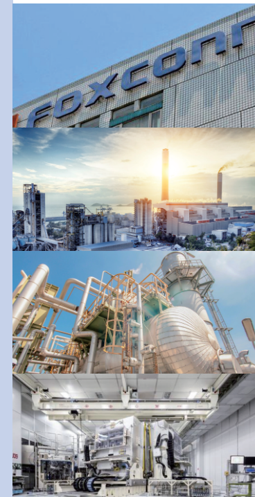
高能耗工厂厂区内变压器、开关柜、配电柜、电机、电容、UPS、PT等
